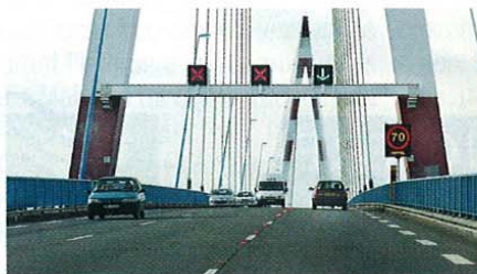
Le pont de Saint-Nazaire et sa gestion dynamique des voies de circulation, une réalisation Lacroix Signalisation.
