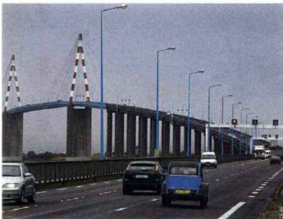
Portique avec feux d'affectation de voies et plots lumineux au sol Gantry with lane assignment lights and illuminated pavement studs
