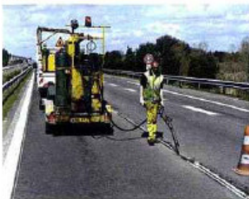
Photo 8 Plot avant scellement Stud before sealing
