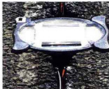
Photo 8 Plot avant scellement Stud before sealing
