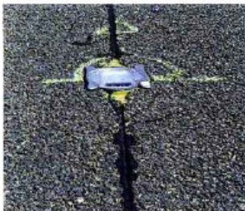
Photos 6 et 7 Rebouchage (en haut) et pose de plot Filling (on top) and placing of stud
