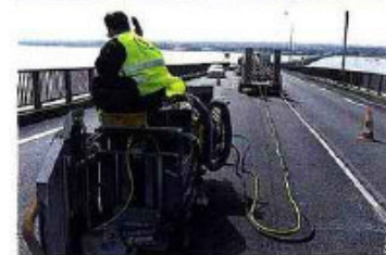
Photos 4 et 5 Carottage (en haut) et sciage Core sampling (on top) and sawing
