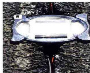
Photo 8 Plot avant scellement Stud before sealing
